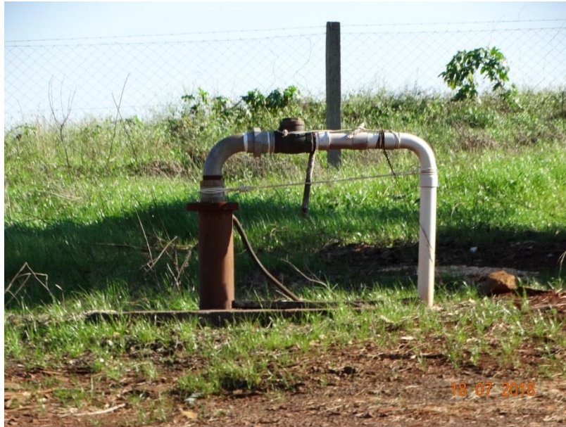
Figura 4. Visualização de um dos poços de abastecimento de água para a área urbana do município de Centenário/RS.
