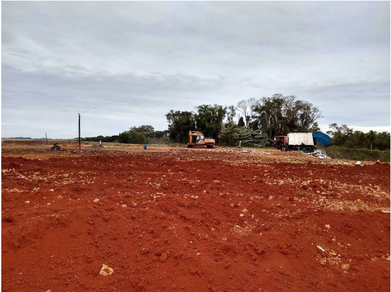
Figura 8. Descarte dos resíduos orgânicos no aterro sanitário em Getúlio Vargas, RS.
