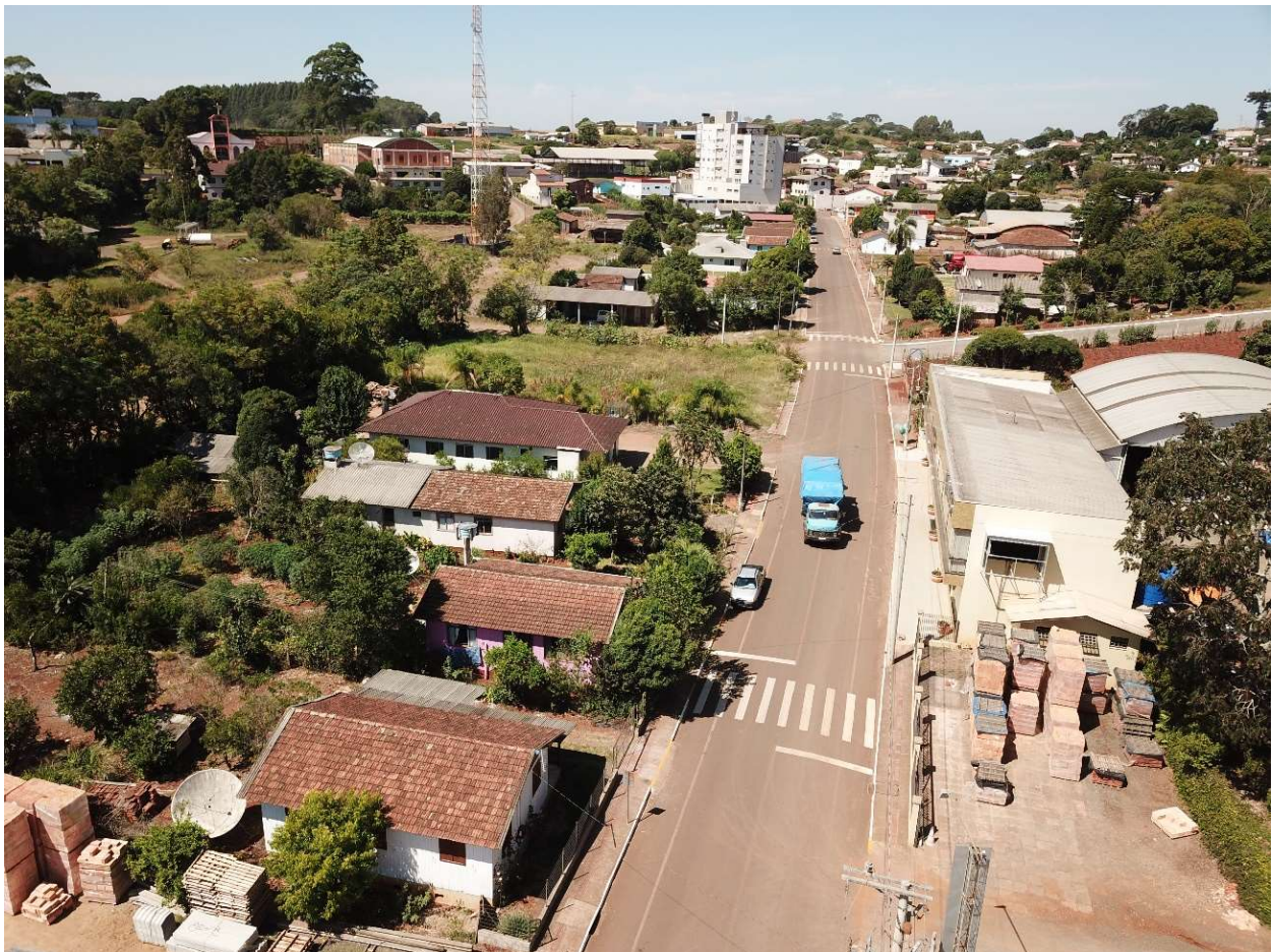
Figura 6. Caminhão realizando coleta nas ruas da área urbana do Município de Centenário.
