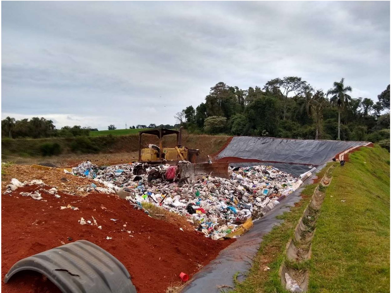
Figura 13. Compactação dos resíduos sólidos no aterro sanitário.
